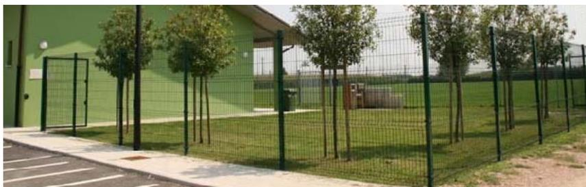
**RECINZIONE ESTERNA FRONTE STRADA ESCLUSIVA** eseguita con muro in C.A. e soprastante recinzione in profili di acciaio zincato e preverniciato con disegni a scelta D.L. coordinati con cancelli apribili a battente/scorrevoli (elettrificati) sia per passaggi pedonali che carrabili: H totale max 1,80 ml..
